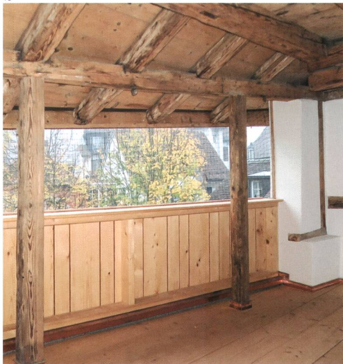
Abb. 17 Der hintere Teil des ersten Obergeschosses nach der Restaurierung. Er wurde neu als offener Bereich mit Treppe, Küche und Essplatz konzipiert. Ein Teil der Balkendecke von 1549/50 konnte restauriert und sichtbar gemacht werden.
