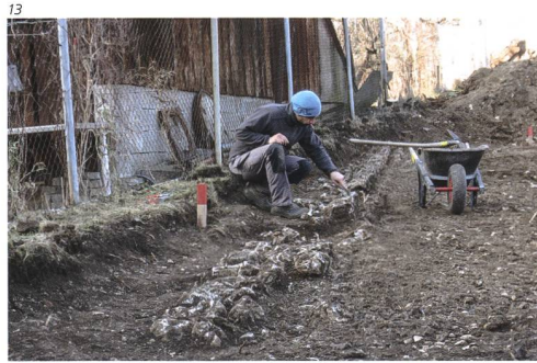
Abb. 13 Oensingen / Gärtnerei Jurt. Westliche Umfassungsmauer des Gutshofs.
