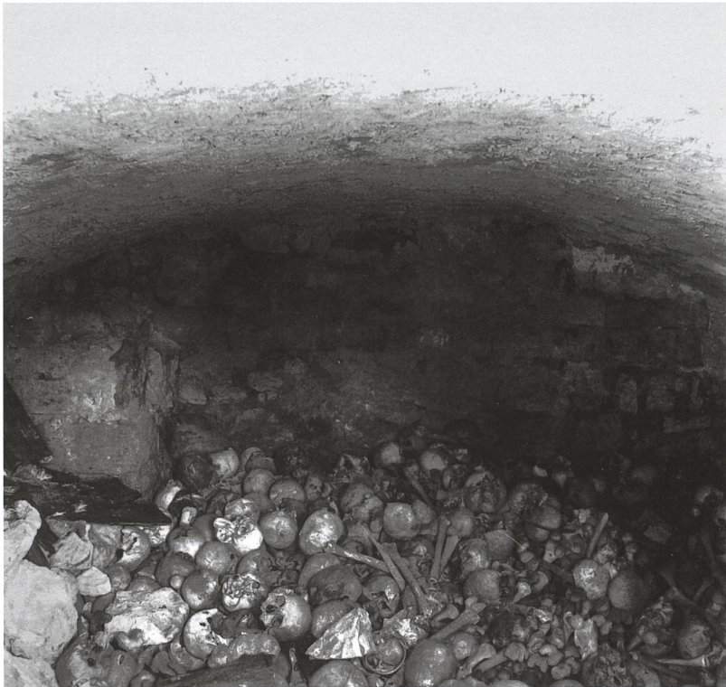
Abb. 6 und 7 Egerkingen, um 1567 an die Pfarrkirche angebautes Bein- haus. Es beinhaltet heute noch eine grosse Anzahl von Gebeinen. Im oberen Geschoss befindet sich die Sakristei.
