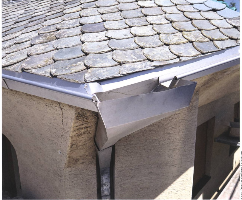
Abb. 12 Detailansicht des Dachs mit neuer Eindeckung aus norwegischem Naturschiefer.
