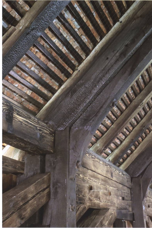
Abb. 14 Am östlichen Stützenjoch mussten Notsicherungen eingebaut werden, da die Stabilität der Brücke an dieser Stelle gefährdet war. Die Massnahmen sind am hellen Holz gut zu erkennen.
