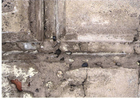
Abb. 12–15 Nordfassade, Zustand des originalen Verputzmörtels nach der Entfernung des Dispersionsanstrichs. Die Oberflächen sind zum Teil stark beeinträchtigt, hervorgerufen unter anderem durch den zu dichten Fassadenanstrich. Zahlreiche ältere Zementflicke sind sichtbar.
