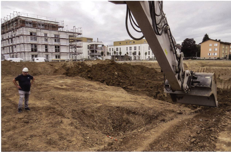
Abb. 2 Blick in die Baugrube, gegen Westen. In der Mitte liegt das Loch mit der weggebaggerten Grabgrube. Bei der grau-braunen Verfärbung an der Oberfläche handelt es sich um den letzten Rest der Grabgrube.
