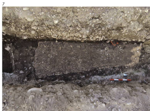
Abb. 7 Gebäude I. Lehmwand W1 (links im Bild), Mörtelboden, Mauerraubgraben M2 (unten). Aufsicht.
