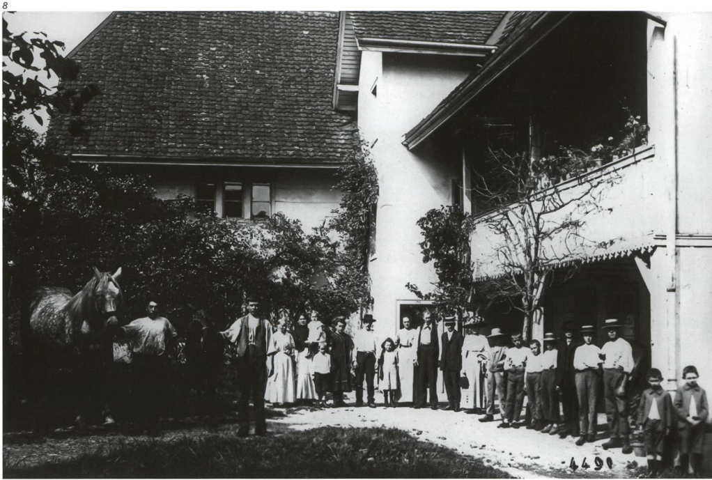
Abb. 8 Hauptgebäude. Zustand um 1900. Ansicht der Südseite vor den Umbauten im 20. Jahrhundert mit der offenen Laube beim Osttrakt.
