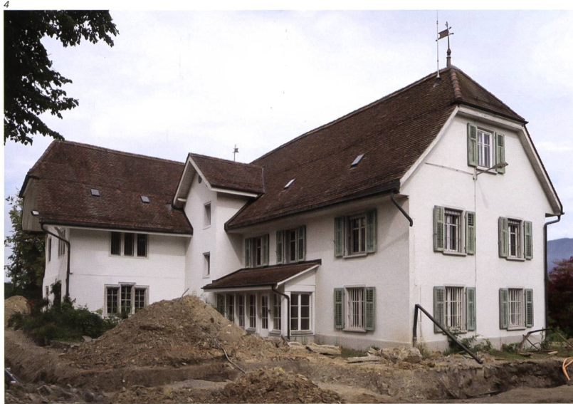
Abb. 4 Schöngrün, Hauptgebäude. Ansicht von Osten, Zustand 2019.
