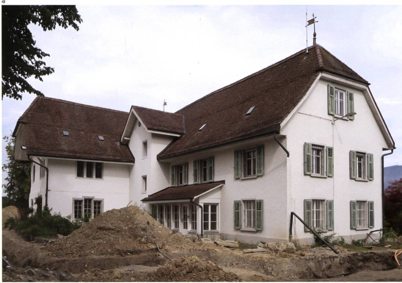
Abb. 4 Schöngrün, Hauptgebäude. Ansicht von Osten, Zustand 2019.
