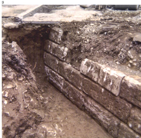
Abb. 9 Mit Bossenquadern verkleidete Frontmauer M5 der St.-Georgs-Bastion bei der Baubegleitung im Jahre 1978. Gegen Nordosten.
