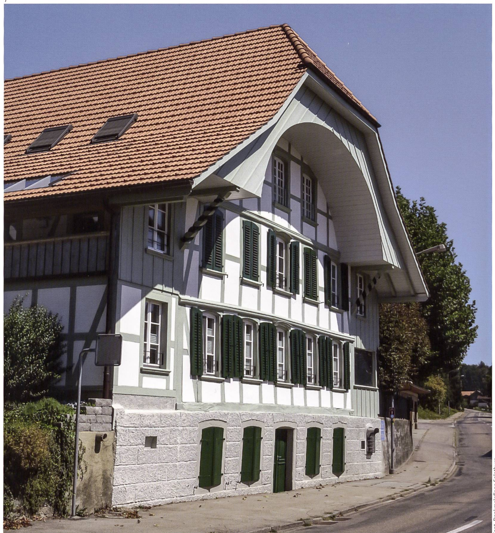
Abb. 1 Ansicht Südwest des Hauptgebäudes Hauptstrasse 17 nach der Instandstellung und Sanierung 2018–2020.
