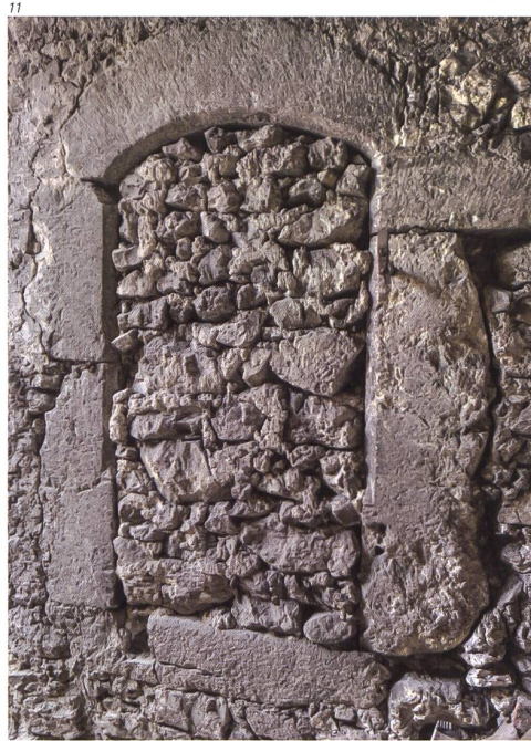
Abb. 11 Olten, Marktgasse 27. Vermauerter Hocheingang zum Obergeschoss des Hexenturms. Zustand 2020.
