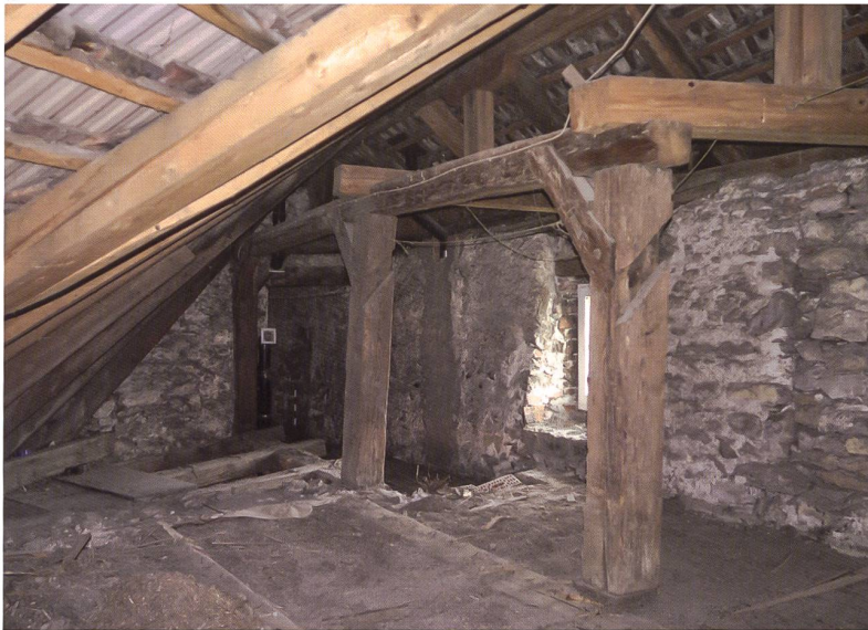
Abb. 13 Olten, Marktgasse 27. Gedeck- te Wehrgangkonstruktion von 1690 über dem Hexenturm. Links im Hintergrund ist die westliche Giebelwand des Spittels zu erkennen. Zustand vor dem Umbau 2020.
