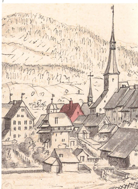
Abb. 1 Lavierte Federzeichnung Emanuel Büchels vom 6. Mai 1756, Ausschnitt. Blick von Süden über die Dünnern, rechts der Obertor- turm und die Bebauung an der Mühlegasse. Rot eingefärbt sind Dach und südseitiger Giebel des historischen Gast- hauses zum Turm. Kunstmuseum Basel, Inv. 1886.7.3.28.
