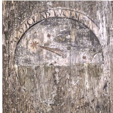
Abb. 23 Bei der Demontage eines Deckenbretts kam im nordwestlichen Hinterhaus eine geklebte Fladerpapierdekoration von 1580 zum Vorschein. In einem von Oberflächenschmutz gereinigten kleinen Teilbereich ist die aufgedruckte Holzmaserierungsimitation gut zu erkennen.
