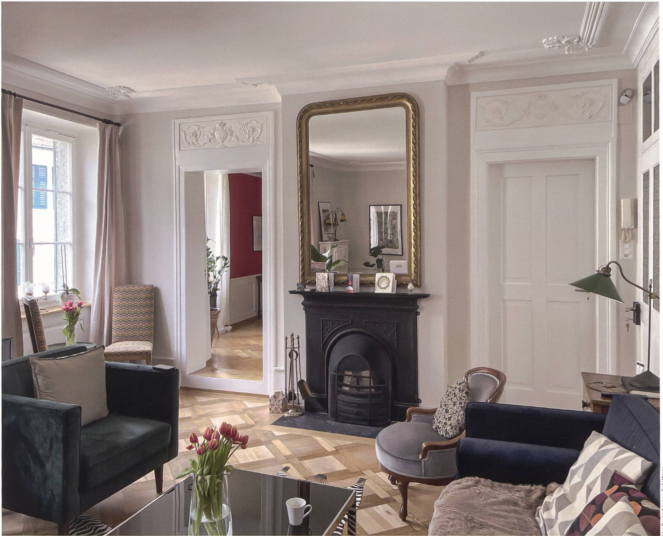
Abb. 30 Stube im ersten Obergeschoss des nordwestlichen Hinter- hauses im Zustand nach der Restaurierung 2020. Die Deckenstuckaturen und die Gipssupraporten sind neue Hinzufügungen.
