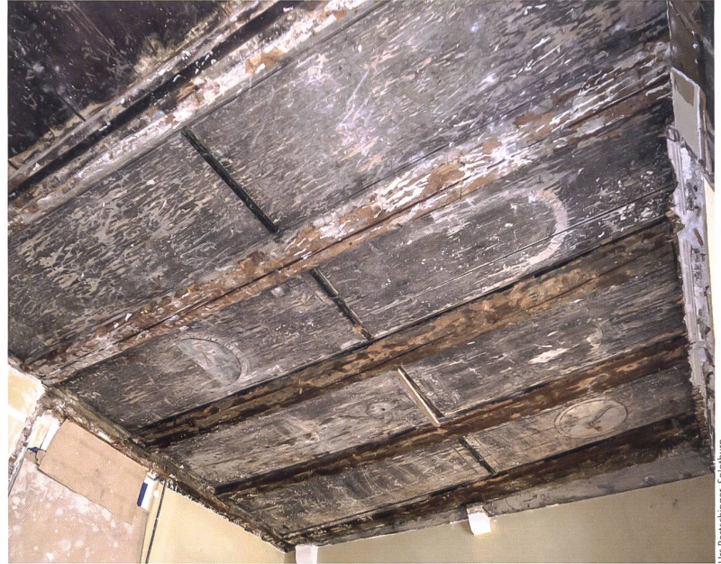
Abb. 23 Bei der Demontage eines Deckenbretts kam im nordwestlichen Hinterhaus eine geklebte Fladerpapierdekoration von 1580 zum Vorschein. In einem von Oberflächenschmutz gereinigten kleinen Teilbereich ist die aufgedruckte Holzmaserierungsimitation gut zu erkennen.
