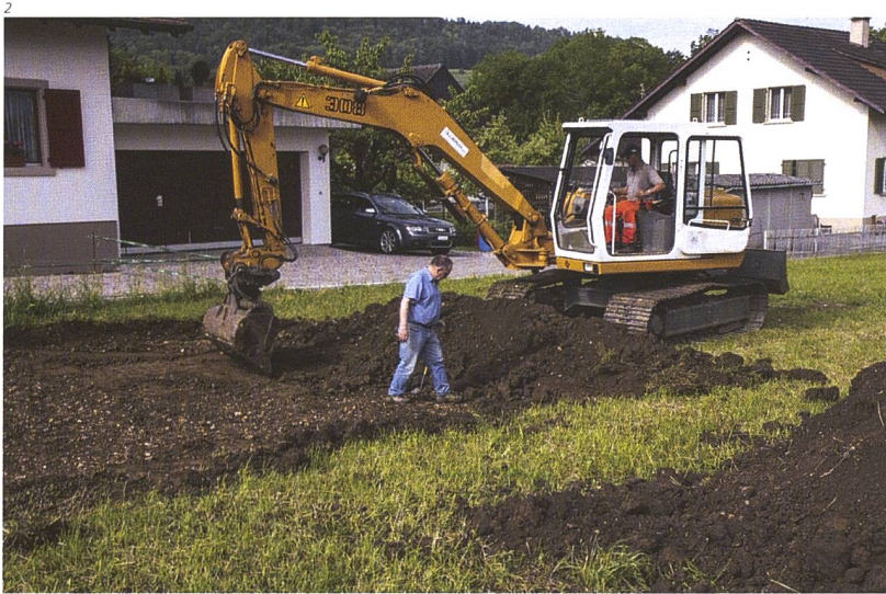
Abb. 2 Humusabtrag in der frühmittelalterlichen Gewerbesiedlung Büsserach/Mittelstrasse im Mai 2010.
