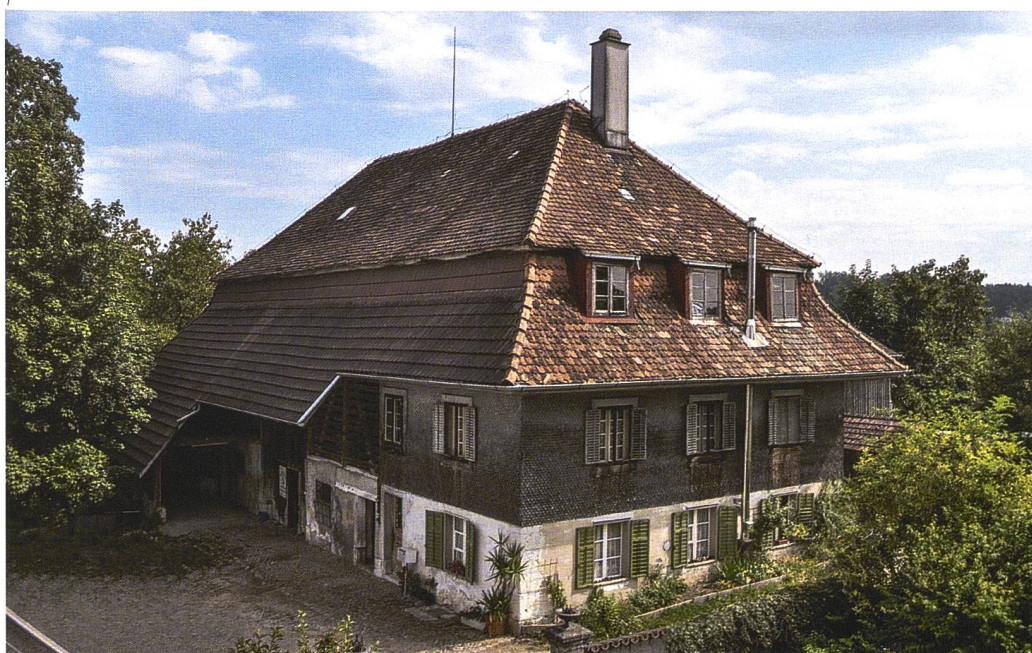
Abb. 1 Biberist, Schlössliweg 17. Der ehemalige Pächterhof des Schlösschens Vorder-Schön- grün in einer Aufnahme von Westen, vor der Restaurierung. Foto 2013.
