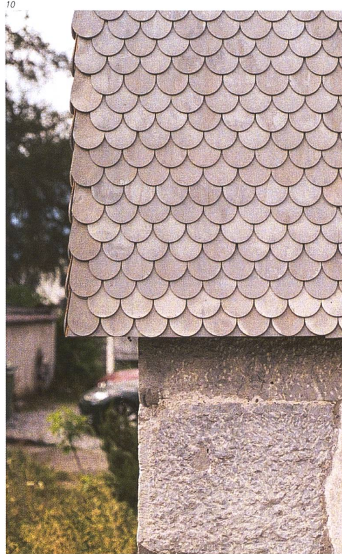
Abb. 9 Blick von Süden auf die Gimwand und auf die Südwest- fassade der Hocheinfahrt. Foto 2023.
