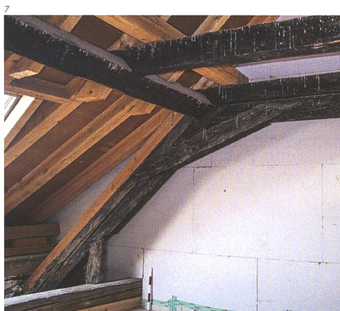
Kant. Denkmalpflege Solothurn
