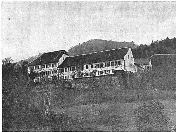
Bâtiment principal (première étape de la restauration)
