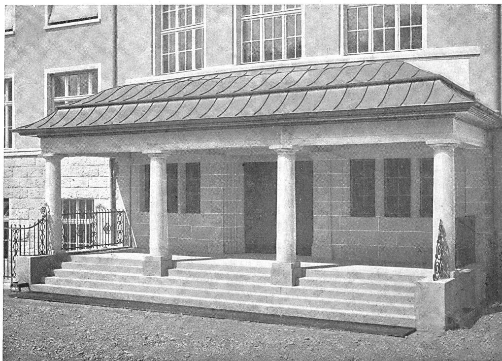
En haut : Façade occidentale, avec voie d'accès
