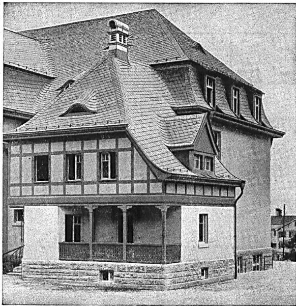
Couverture en Éternit vieux style allemand :: Les faites, :: couloirs et lucarnes entièrement couverts en Éternit ::
