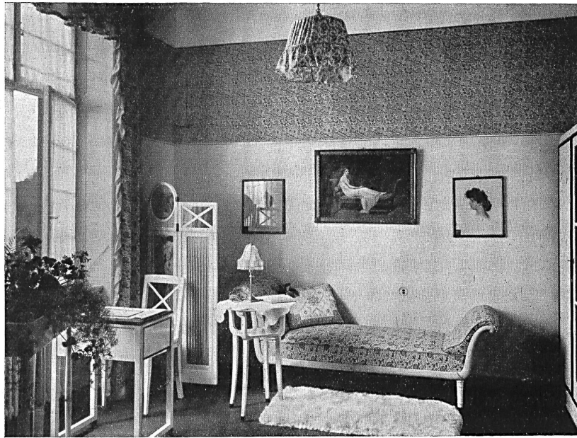
Cabinet de toilette au II e étage
