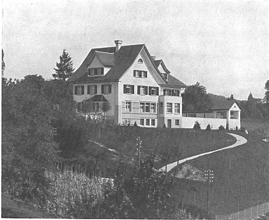
Vue d'ensemble, du sud-ouest
