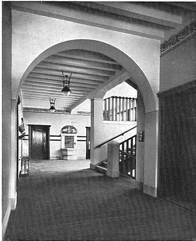
Ecole de Buchthalen Vestibule au rez-de- chaussée et départ :: d'escalier ::
