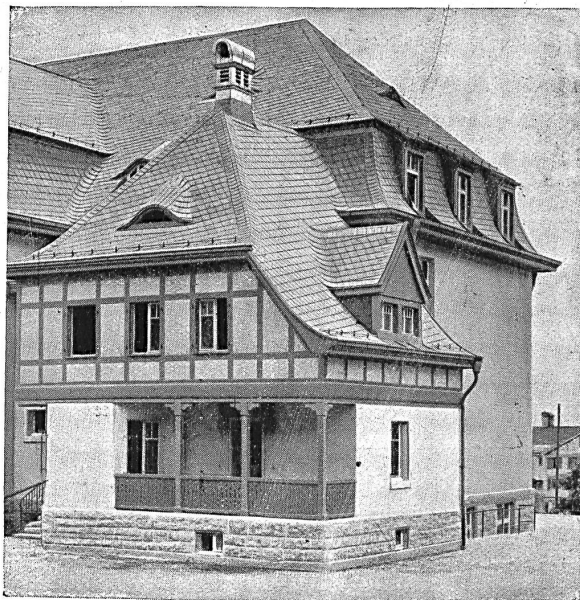
Couverture en Éternit vieux style allemand :: Les faîtes, :: couloirs et lucarnes entièrement couverts en Éternit ::
