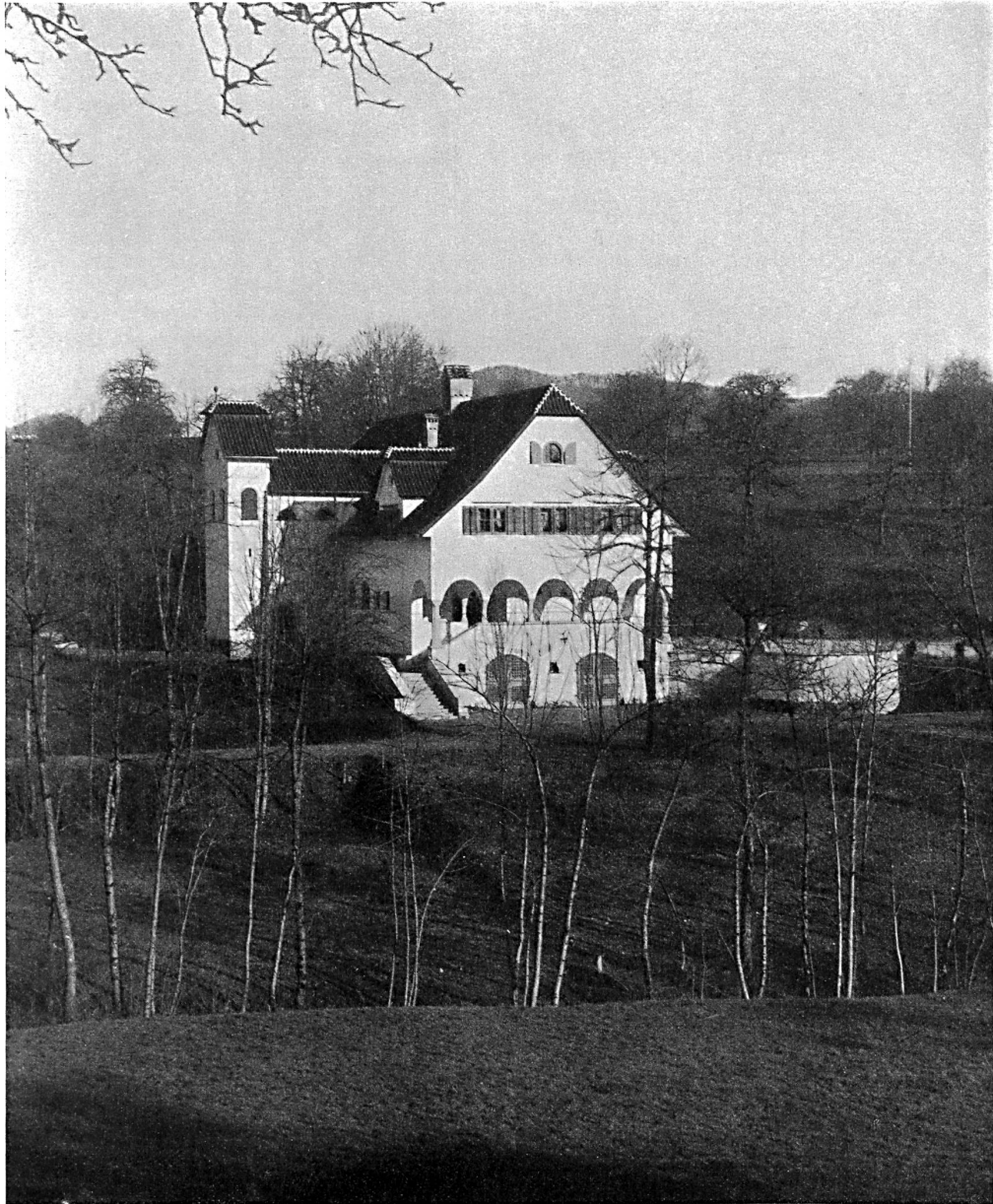
L'école de Rifferswil (canton de Zurich). — Vue de l'ouest. Architecte: F. B. Frisch, Zurich.
