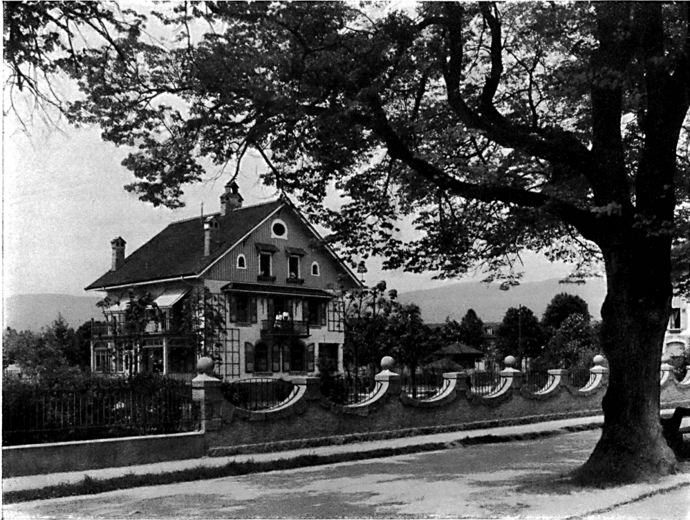
Maison de M. Hermann Hinderer à Yverdon. — Architecte: R. Pilloud, Yverdon.
