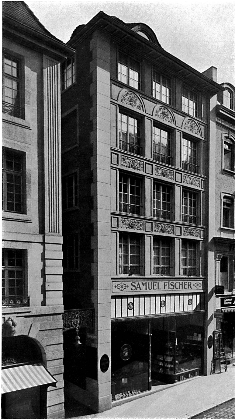
Maison de commerce Samuel Fischer, Freiestrasse à Bâle. Architectes: Suter & Burckhardt à Bâle.
