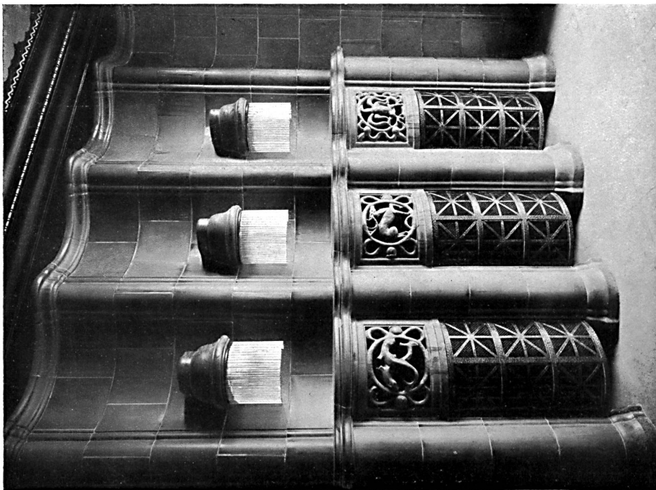
Détail de l'entrée du côté du Beatenplatz.
