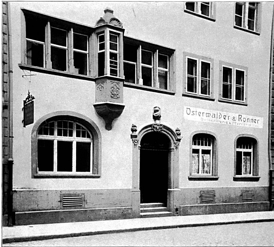
Façade sur la rue.
