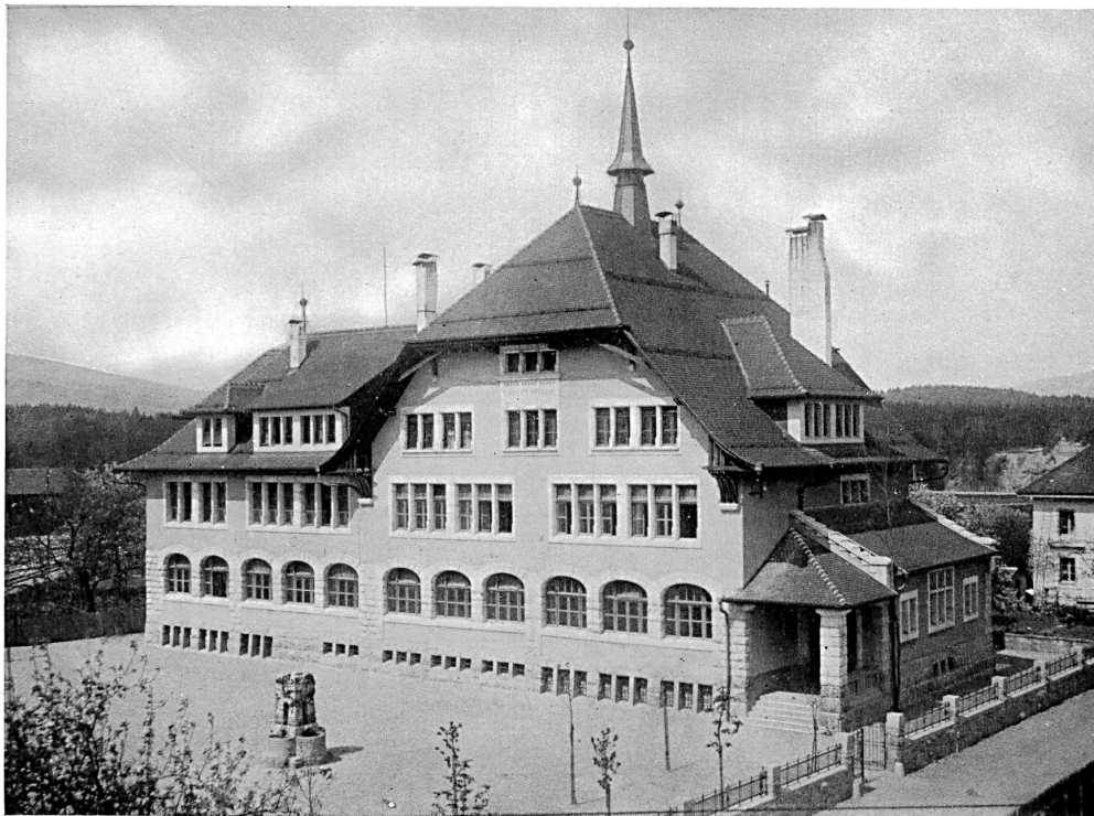
Bâtiment d'école à Broc. — Vue générale. Architectes: Waeber & Gribi, Bulle.
