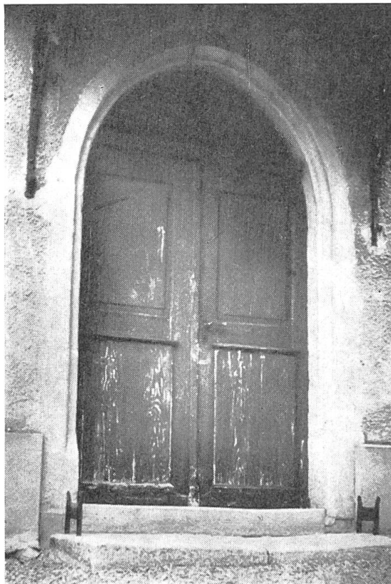
Bild 24. Der 1725 errichtete Haupteingang auf der Westseite. Dazu waren teilweise die Gewände einer alten gotischen Türe verwendet worden. Bei der Renovation von 1958 wurden völlig neue Gewände eingesetzt.
