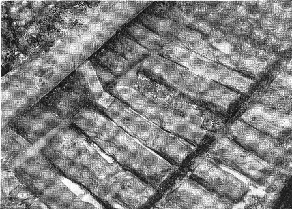
*Bild 9.* Der im Jahre 1957 aufgedeckte Bohlenweg an der alten Strasse beim Kurhaus Langenbruck. Spurweite der Karregeleise innerkant 105,4 cm.
