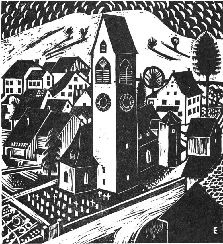
Bild 3. Walter Eglin, Rümlingen, vom Viadukt aus gesehen . Holzschnitt 17,7 mal 19,4 cm, Kantonsmuseum Baselland. Der Schnitt stammt aus den dreissiger Jahren und war für eine Konfirmationsurkunde bestimmt. Infolge der baulichen Aenderungen am Pfarrhaus und der Strassenkorrektur der Hauensteinstrasse hat das Bild bereits historischen Wert erhalten.
