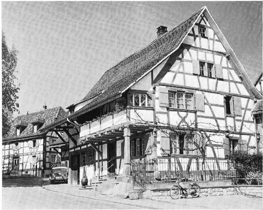
Bild 9. Fachwerkhaus: Alte Schmiede an der Schönenbuchstr. 2, in Allschwil. Der Bau stammt aus dem 17. Jahrhundert. Im Hintergrund Schönenbuchstrasse 5, ein Bauernhaus mit Baudatum 1673, dessen Fachwerk 1957 freigelegt wurde.
