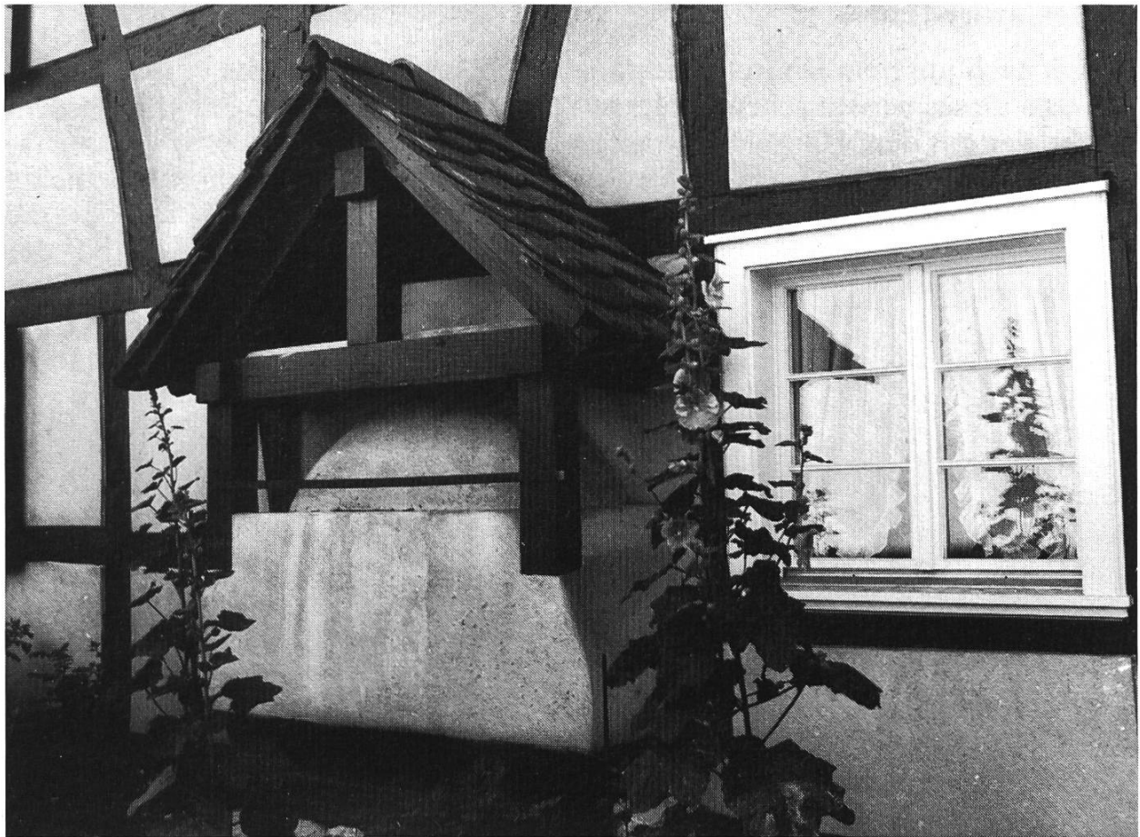
Bild 1. Backofen an der westlichen Aussenmuer des Fachwerkhausees Baslerstrasse 48 (Ortsmuseum).
