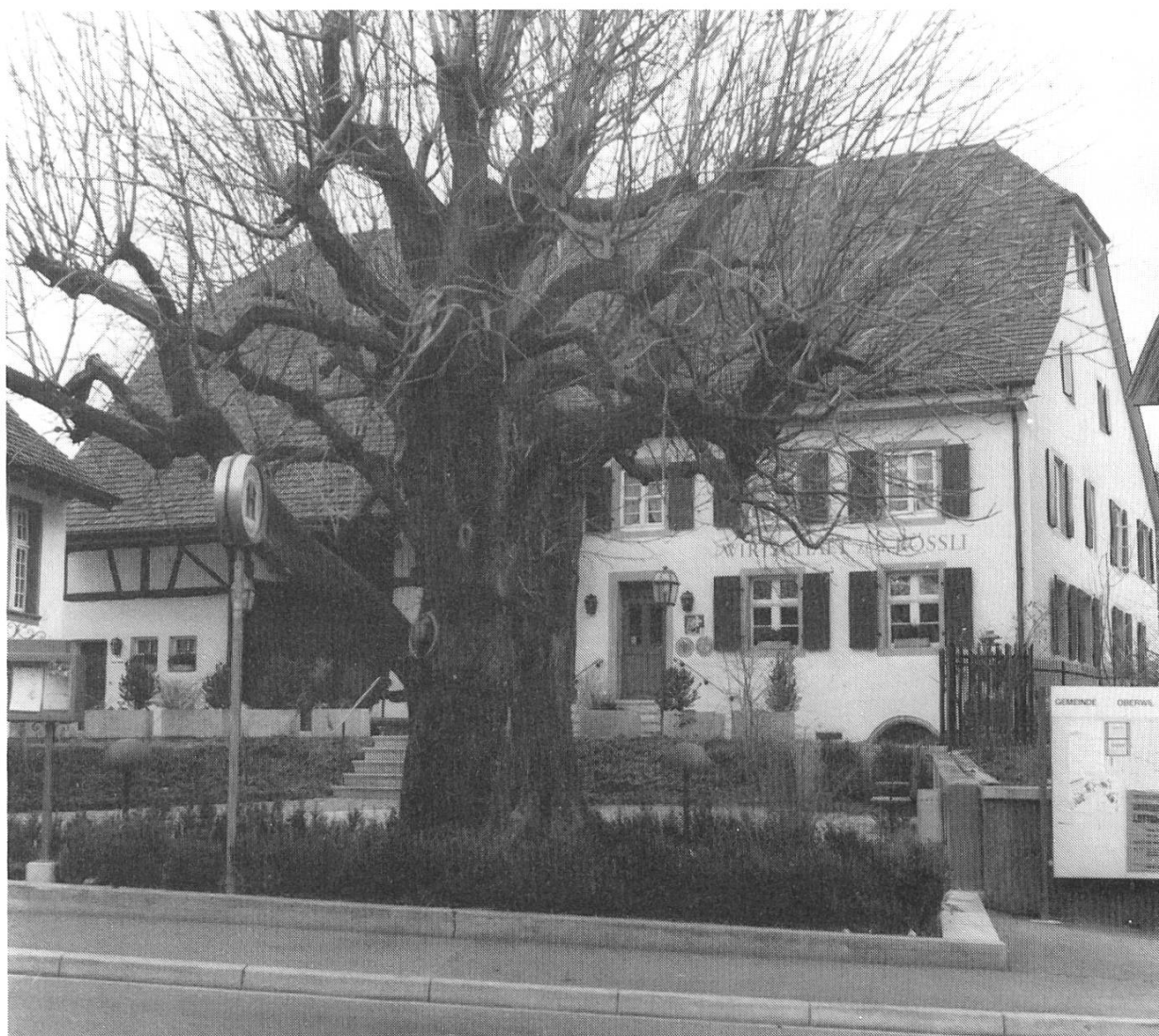
Bild 10. Zum neuen Dorf- und Begegnungszentrum gehört neben dem Spritzehüsli die renovierte Wirtschaft zum Rössli mit einem eindrucklichen Scheibenzyklus Döblin in der Wirtsstube. Eigentum der initiativen Bürgergemeinde.
