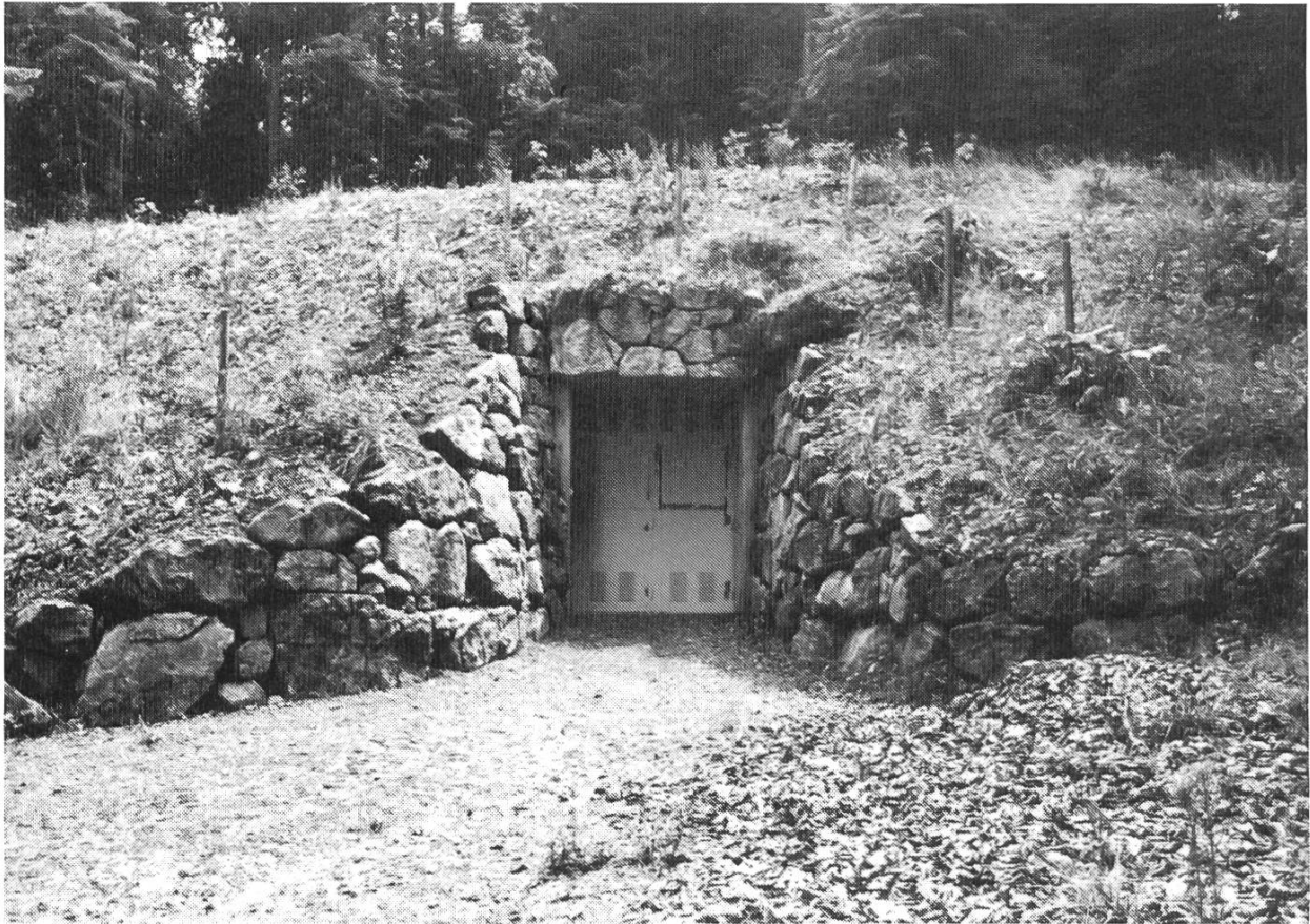
Abb. 10. Reservoir Chastelen, 1986 in Betrieb genommen (Photo K. Wyttenbach).
