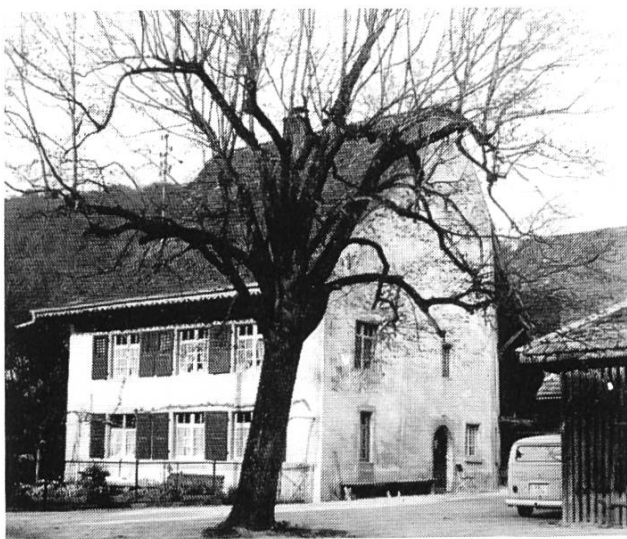
Bild 1. Das Haus zu «Tülliken», Hauptstrasse 84, in Nieder-Diegten im April 1974. Foto Peter Stöcklin.
