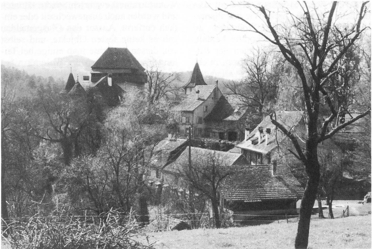
Die Schlossanlage vor Beginn der nun erfolgten Massnahmen (Archivaufnahmen 1994, D. Wunderlin)
