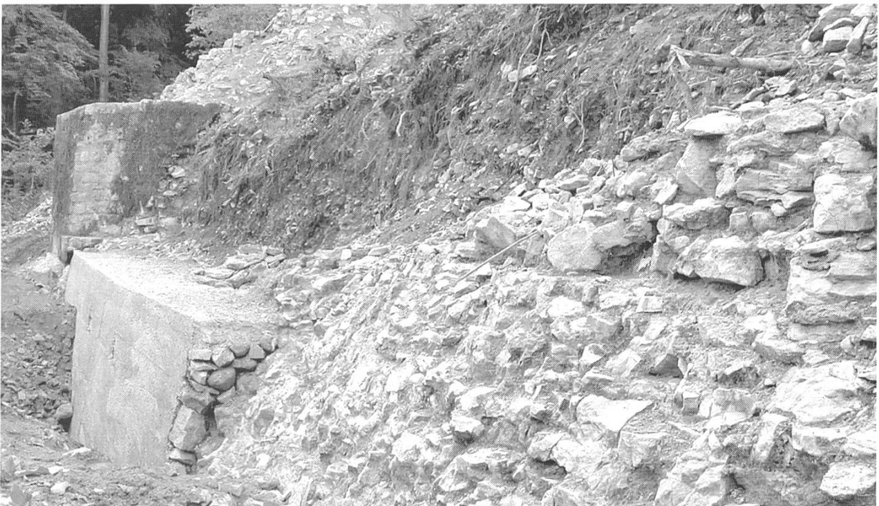
Abb. 6: Buus/Ormalingen/Hemmiken, Farnsburg. Das aus Beton erstellte Fundament für die Rekonstruktion der östlichen Beringmauer. Rechts Reste des Mauerkerne der originalen Mauer und des abgeschroteten anstehenden Felsens.
