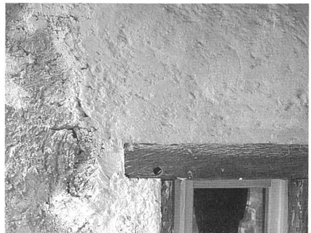
Abbildung 6: Gleiche Stelle wie Abb. 5, nach der Verputzergänzung.
