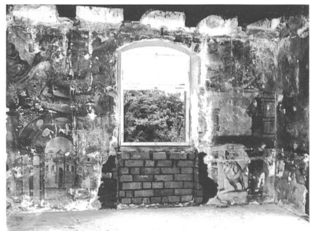
Grisaille-Wandmalereien im Südwestzimmer nach Abbruch der Innenwand, der Vertäferung der Außenwände und der Kassettendecke. (Foto 1966).
