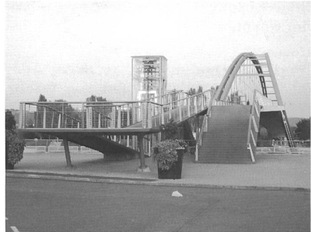
Dreiländerbrücke, Weil (D) nach Huningue (F) (Leonhardt, Andrä und Partner, Berlin/Feichtinger Architekten Paris)
