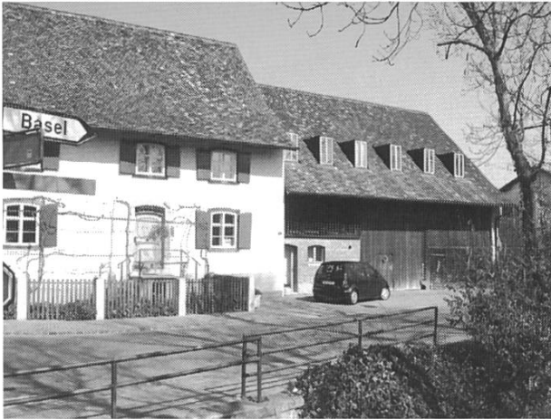
Umbau Fraumattenstrasse 1, Biel-Benken (Erny + Schneider AG, Architekten Basel).
