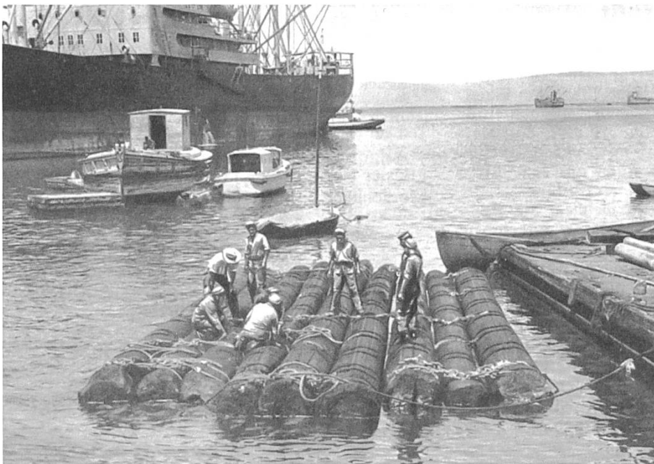
Bild 7: Sicht 1947 auf die zusammengefügte Balsastämme von «Kon-Tiki» während des Zusammenbaus in Peru (Repro aus: Heyerdahl, 1949).
