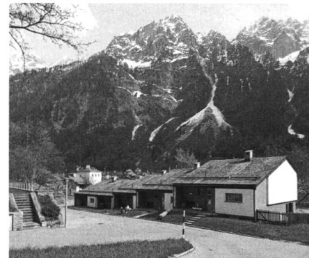
EWZ-Wohnsiedlung in Vicosoprano, Nordansicht der oberen Hauszeile mit fünf 4-Zimmerwohnungen Typ B, Aufnahme 2008 (Foto: Ralph Feiner)
