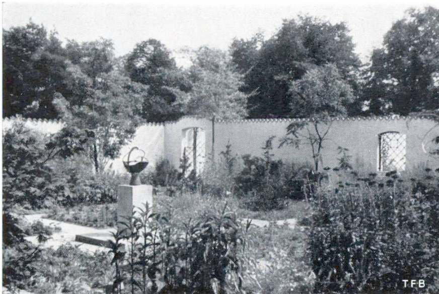
Fig. 7 Haut mur de clôture de jardin dans une propriété de maître Le faite est recouvert de tuiles pour éviter la pénétration de l'eau
