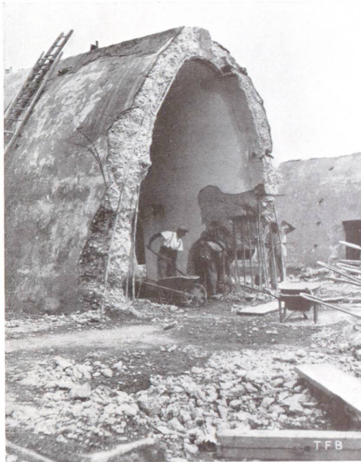
Fig. 4 Démolition d'une voûte en béton armé au moyen de marteaux pneumatiques.
