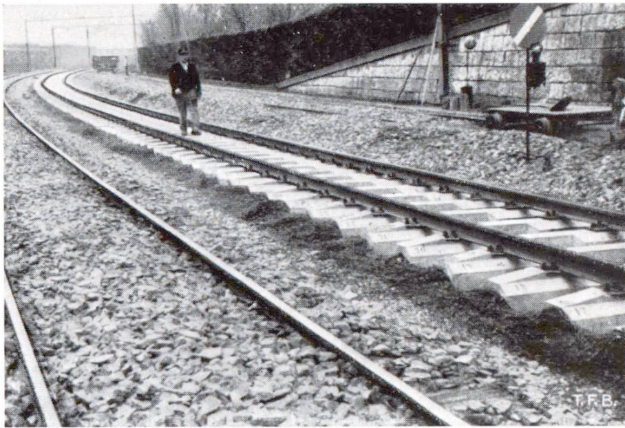
Fig. 7 Tronçon d'essai pour le plus fort trafic et dans une courbe.
