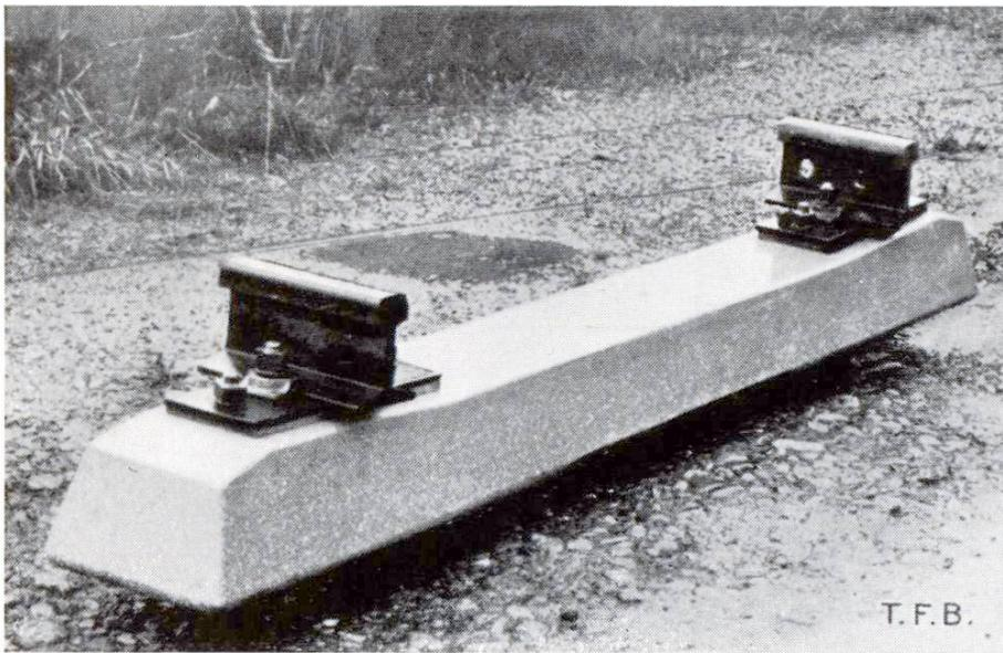
Fig. 5 Traverse transversale en béton spécial. Section trapézoïdale.
