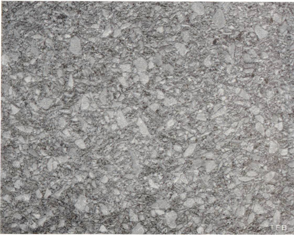
Fig. 4 Béton de parement, traité au jet de sable. 24 heures après sa mise en œuvre et meulé grossièrement
