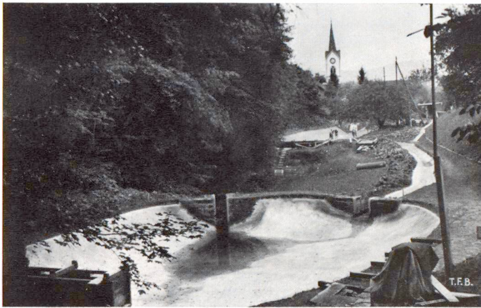
Fig. 4 Étanchement d'étangs à poissons
