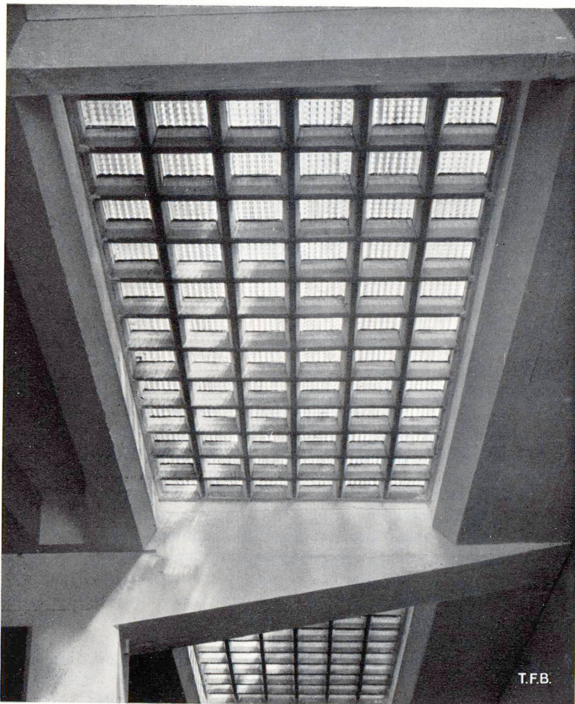
Fig. 7 Lanterneau en béton translucide du type 1, fig. 2 Carreaux de verre sur poutrelles en béton armé
