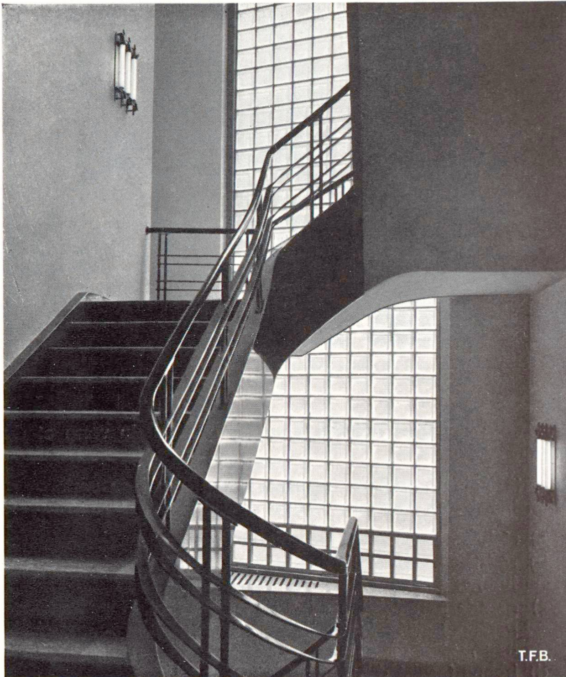
Fig. 5 Paroi de cage d'escalier en béton translucide
