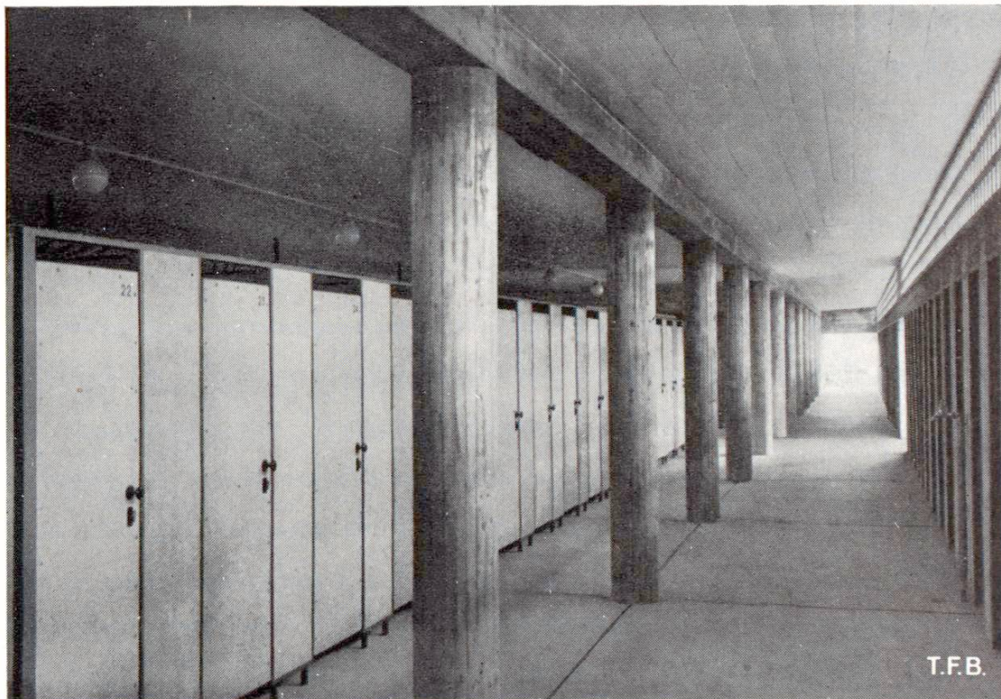
Fig. 8 Bains d'Olten. Vue intérieure de la halle des cabines. Dallage en béton. Colonnes, poutre et plafond en béton armé brut. Portes et revêtements des cabines en éternit
