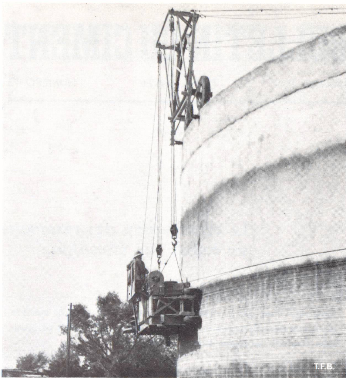
Fig. 1 Appareil pour le bobinage sous haute tension du fil d'acier des réservoirs en béton précontraint
